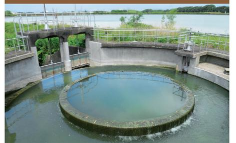
老ノ口分水所は、淡河川や山田川の水を主に神出町や岩岡町、および稲美町などに、農業用水として分配するための施設です。1895年に完成し、1958年に六角形煉瓦積みものから円筒式コンクリート分水路に改築されました。
